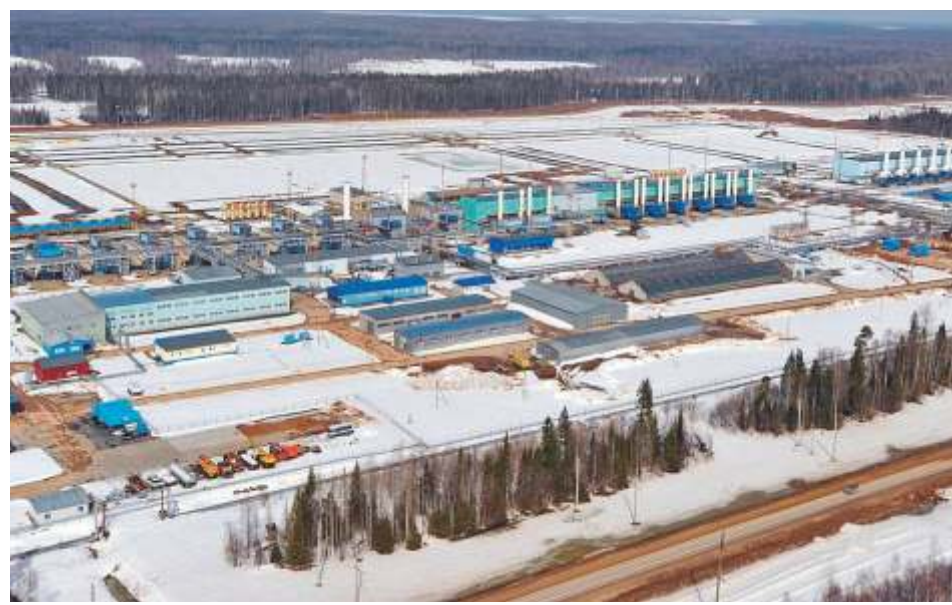
ГАЗПРОМ. Компрессорная станция «Нюксеница» магистрального газопровода «Ухта-Торжок»
