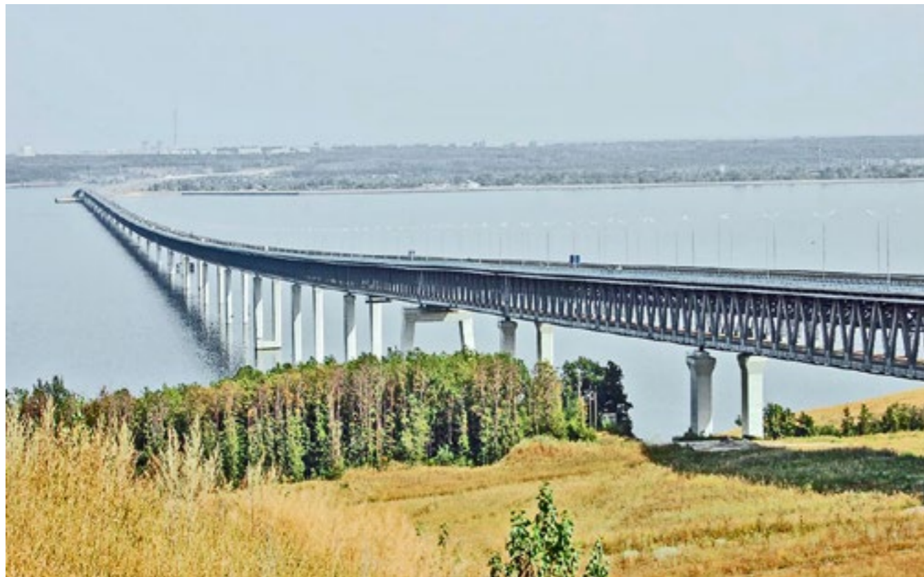
Мостовой переход через р. Волга, Ульяновск
