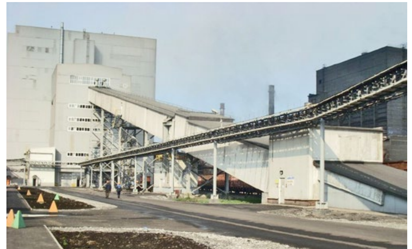
ЕВРАЗ. Западно-сибирский металлургический комбинат
